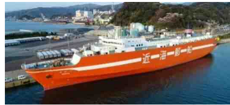
出典：福井県ホームページ 敦賀港と博多港を結ぶ貨物船の新航路が 2019年4月1日（月）に開設
