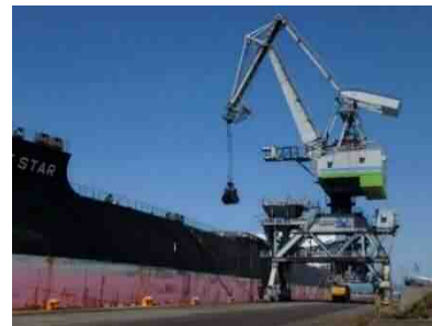
老朽化した多目的クレーンの状況
