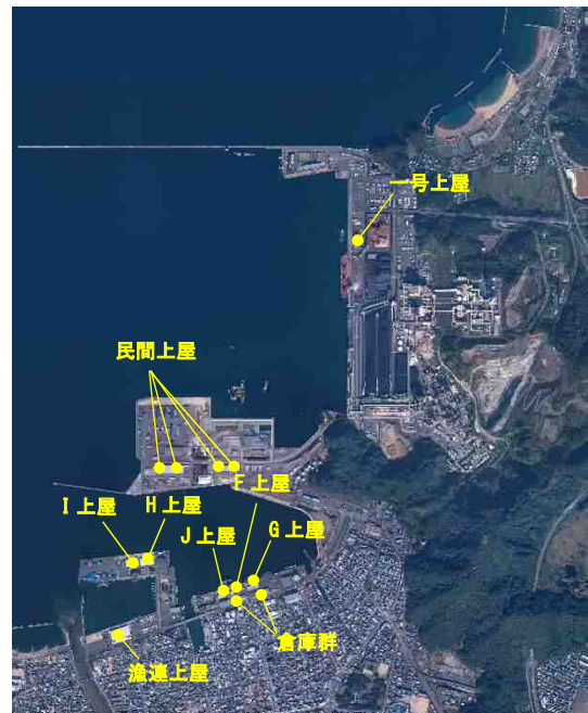
港内の倉庫の配置状況
