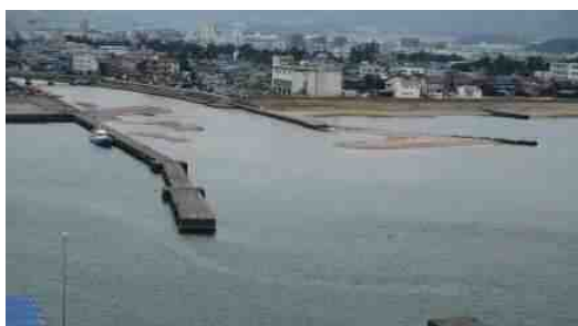
笹の川河口の土砂堆積状況
