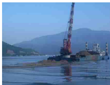
笹の川の河口土砂浚渫状況
