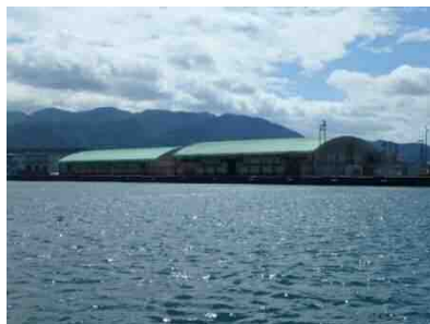
老朽化した倉庫の状況
