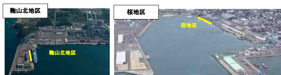
敦賀港における耐震強化岸壁の整備状況
