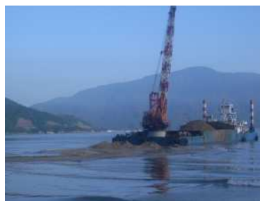
笹の川の河口土砂浚渫状況
