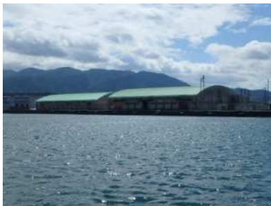
老朽化した倉庫の状況
