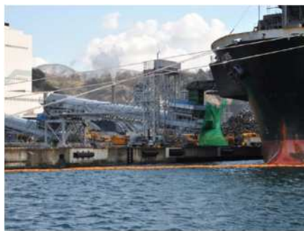
木質チップ船からベルトコンベアにチップを降ろしている状況
