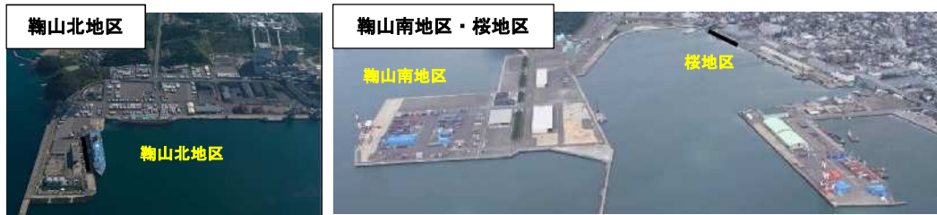
敦賀港における耐震強化岸壁の整備状況
