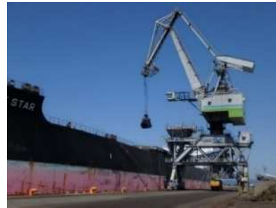
老朽化した多目的クレーンの状況
