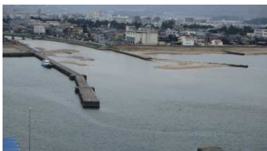
笹の川河口の土砂堆積状況
