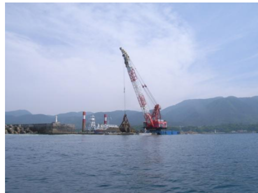
浚渫砂投入状況
