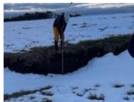
着陸帯において最大75cmの段差
