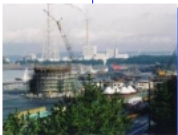
●セメント会社によるサイロ建設中(平成 13 年)
