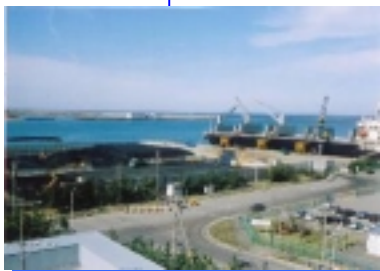
●石炭荷役状況；北1号岸壁、北1号野積場貯炭場
