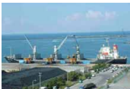
輸入石炭の荷役作業と貯炭場
