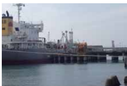
油槽船の係留施設(ドルフィン)
