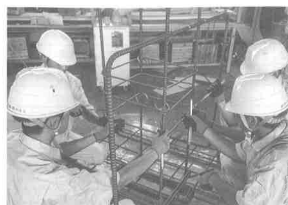
鉄筋施工実習
