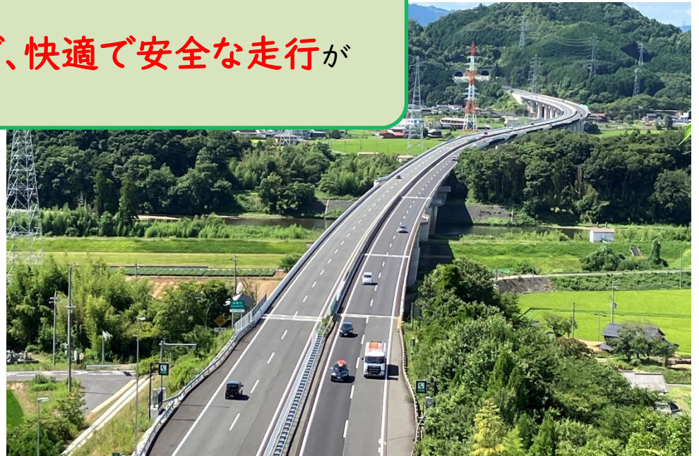
4車線区間(舞鶴若狭自動車道 福知山IC~綾部IC間)
