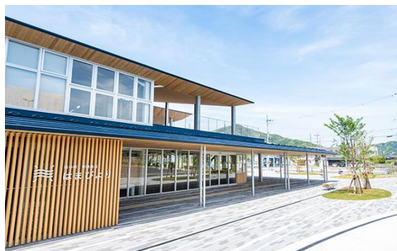
道の駅 「若狭美浜はまびより」 (美浜町) 令和5年6月オープン
