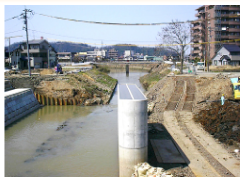
追加予算により早期完了を目指す江端川の拡幅工事
