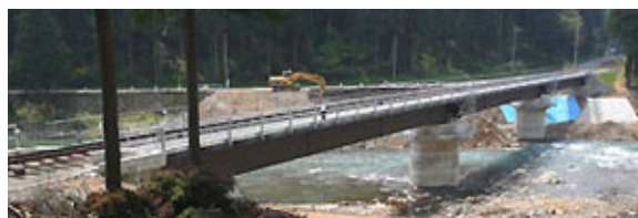
新しく架け替えられた第3足羽川橋梁
