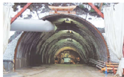
進む新北陸トンネルの工事
