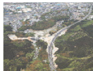
来年の開通に向け工事が進む舞若道(敦賀JCT付近)
