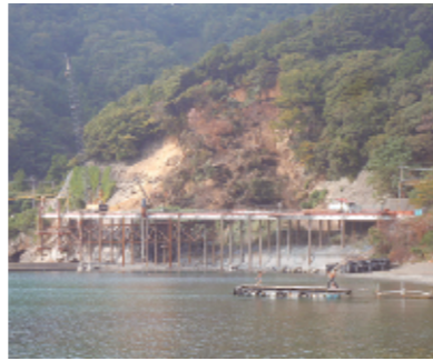
仮設橋の開通に向け、急ピッチで工事を進めた県道常神三方線(若狭町遊子)
