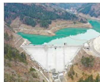
整備中の河内川ダム
