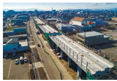
福井高柳高架橋工事
