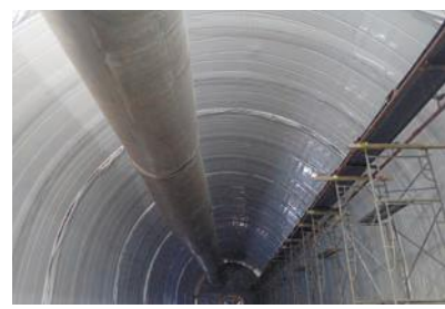
新北陸トンネル工事
