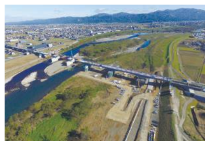
九頭竜川橋りょう工事
