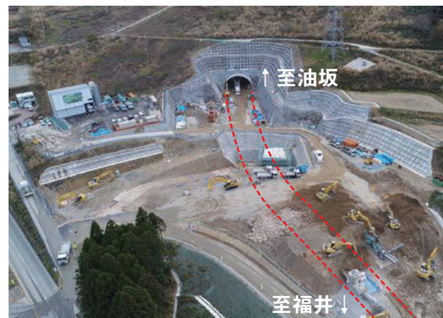
大野油坂道路(荒島第2トンネル(仮称)付近)
