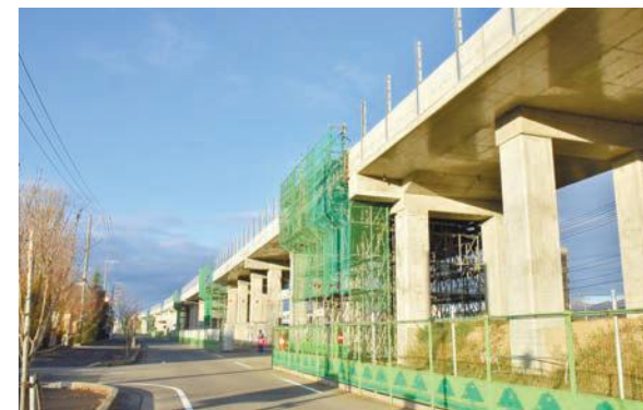
北陸新幹線の高架橋工事(福井市高柳)
