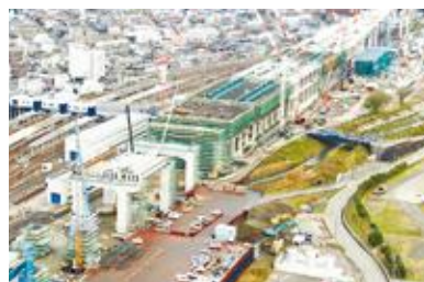
敦賀駅高架橋
