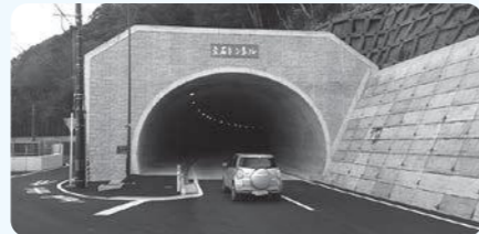
昨年12月に開通した原子力災害制圧道路
