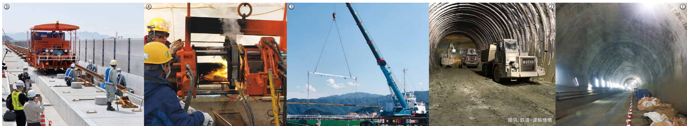
①②工が進む新北陸トンネル ③船で輸送されたレールを陸揚げ(敦賀港) ④約1200℃の高温で行うレールの溶接作業 ⑤県内で最初にレール敷設が始まった福井高柳高架橋
