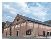
▲赤レンガ倉庫(敦賀市)
