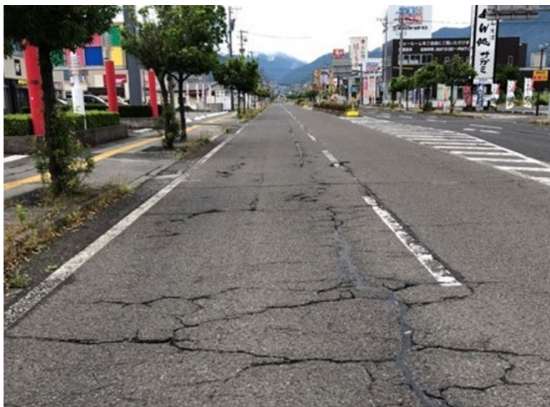
【舗装・区画線補修対象(例)】
