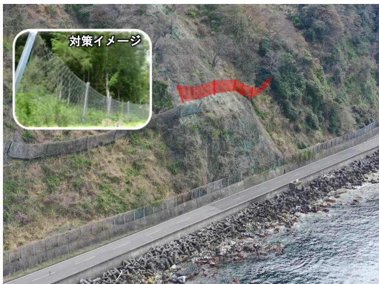
一般県道大谷杉津線（しおかぜライン） （落石防護柵工 1億400万円）
