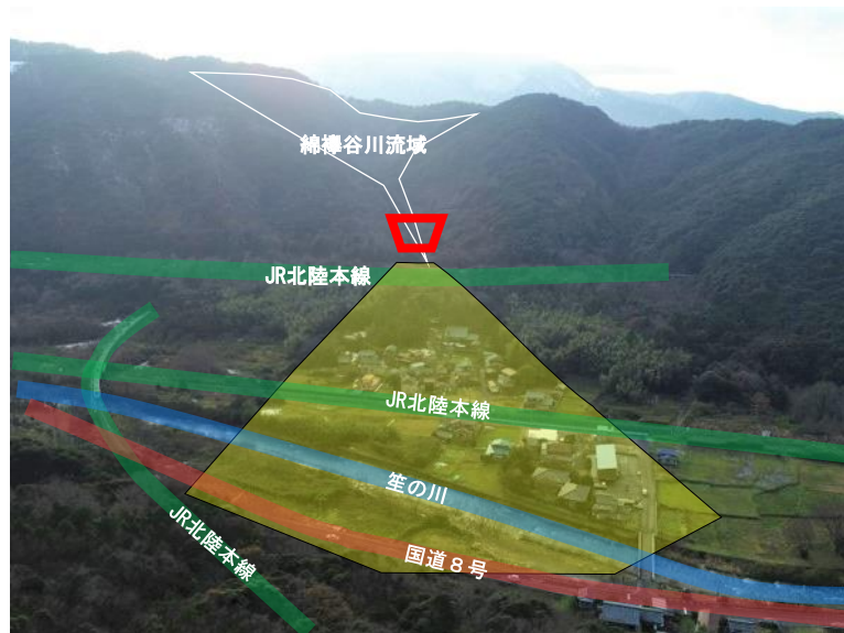
たすきたにがわ 綿櫛谷川（敦賀市鳩原） （通常砂防事業（砂防堰堤）1億1,600万円）
