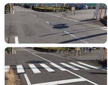
横断歩道の新設 (上：整備前 下：整備後)
