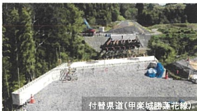
付替県道(甲斐城勝蓮花線)
