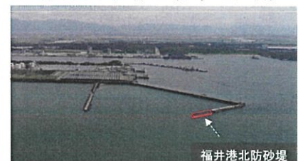
福井港北防砂堤
