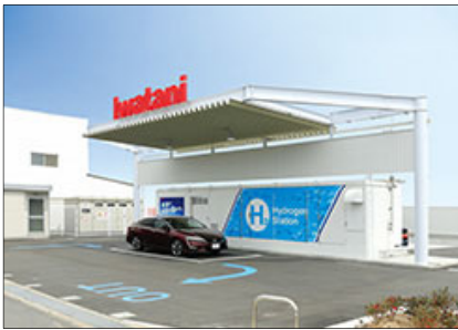
【イワタニ水素ステーション岡山南】 ©Iwatani Corporation
