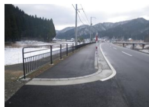
通学路の歩道整備
