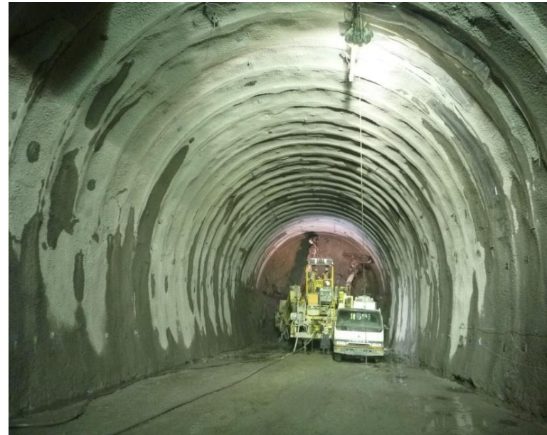
【新北陸トンネル工事(奥野々工区)】
