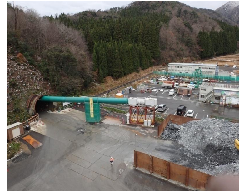
【新北陸トンネル工事(葉原工区)】
