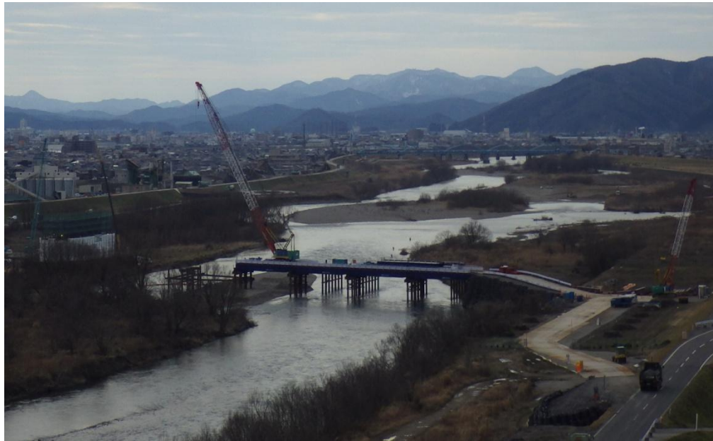
【九頭竜川橋りょう工事】
