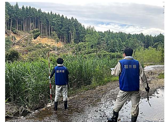
地震被害の現地調査
