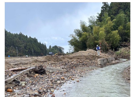
豪雨後の現地調査
