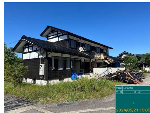
現地調査(町営住宅)
