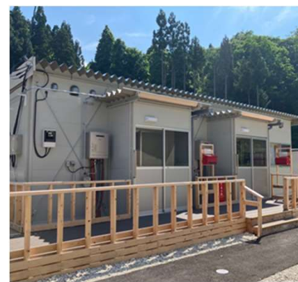
被災者用応急仮設住宅
