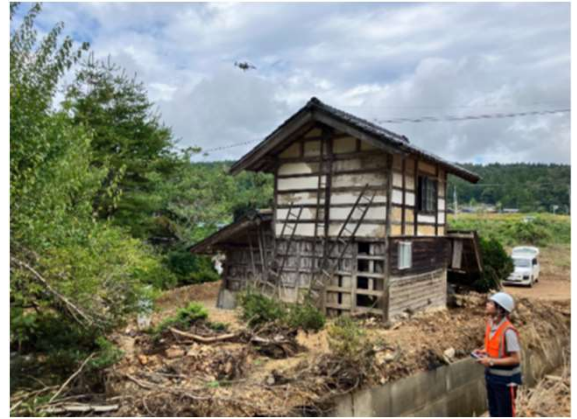
被災現場でのドローン操縦
