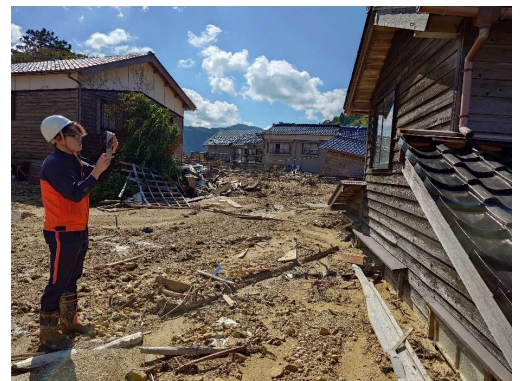
土石流により1階部分が埋塞
