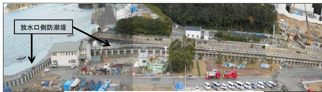
放水口側防潮堤
