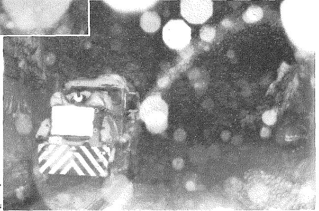
ロータリー車での拡幅作業
