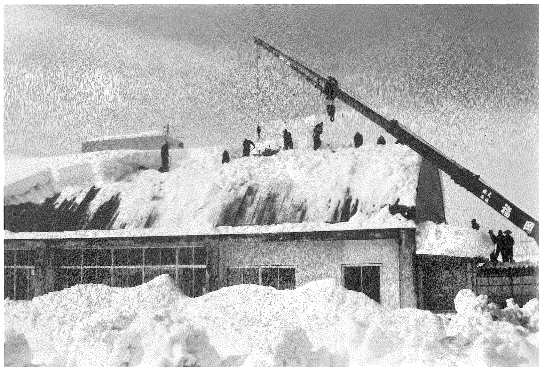
鯖江東小学校体育館除雪作業(鯖江市)
