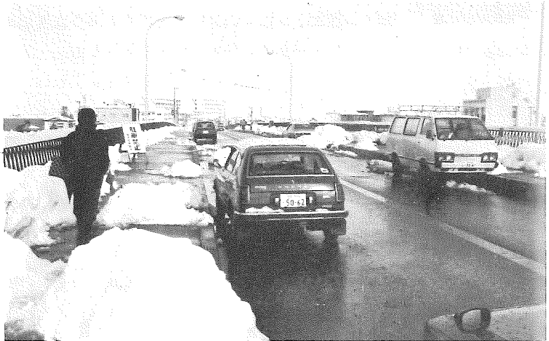
橋の融雪装置により確保された道路(福井市)
