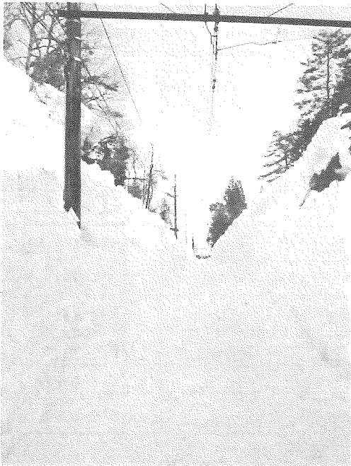
手作業を終了しラッセル車の運転を待つ 発坂切割(発坂～勝山間56. 2. 3)
