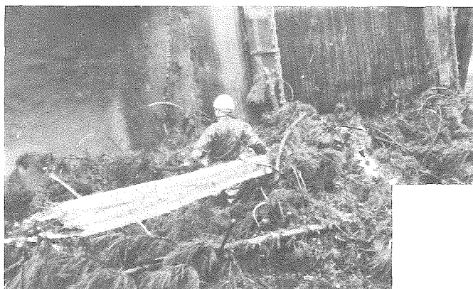
小和清水発電所 水槽内流木堆積 (S.56.1.8)
