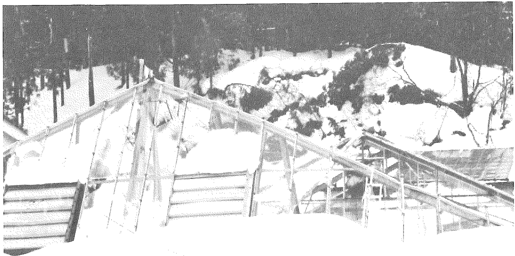
鉄骨ハウスの倒壊（福井市大瀬町）
