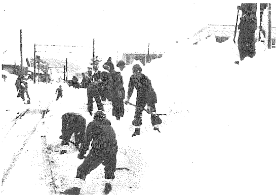
自衛隊の協力による段積による除雪作業 (56. 1. 14西鯖江構内転轍器付近)
