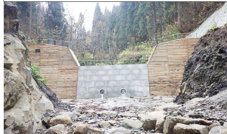
【治山ダム工（大野市角野）】
