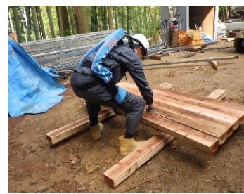
アシストスーツによる作業の軽労化
