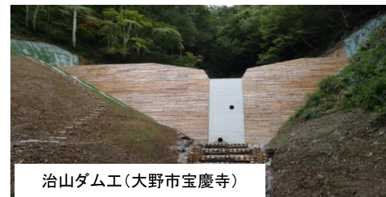
治山事業(治山ダム工)施行事例
