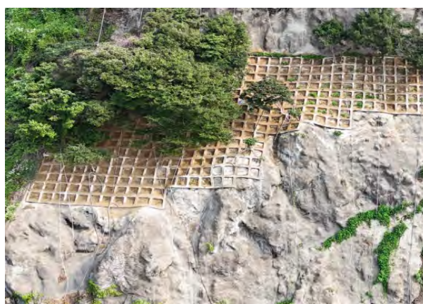
治山施設【法枠工等】の補修 (福井市浜北山)
