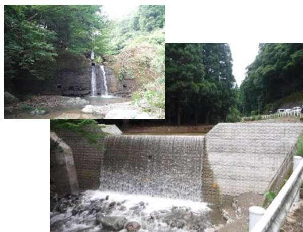
治山施設の補修 (高浜町関屋)
