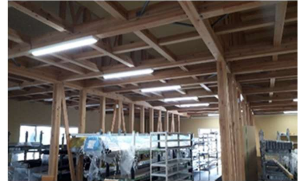
施工事例（シアターハウス(株)事務所兼倉庫）
