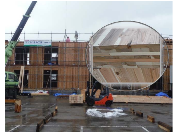
CLT建築（坂井市）
