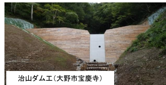
治山事業(治山ダム工)施行事例
