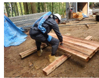
アシストスーツ等による作業の軽労化
