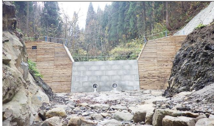
【治山ダム工（大野市角野）】
