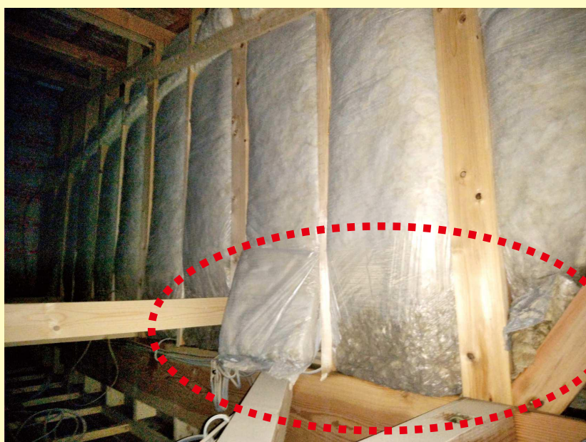
水(泥水)を吸った断熱材
