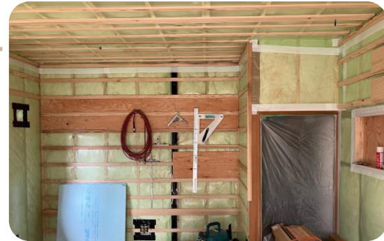
断熱・気密施工後の壁・天井
