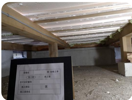
改修前の床下
