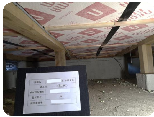
既存の断熱材に追加で断熱材を施工
