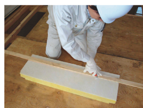
断熱材の切断と施工
