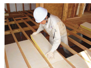
断熱材の切断と施工
