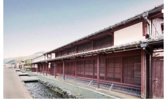
改修後(改修なし)
