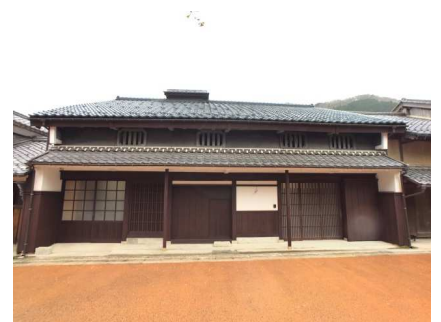
改修後(改修なし)
