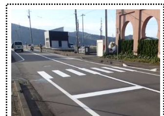
移動経路の横断歩道新設
