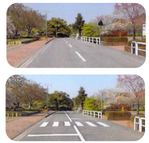
横断歩道の新設 (上：整備前 下：整備後)
