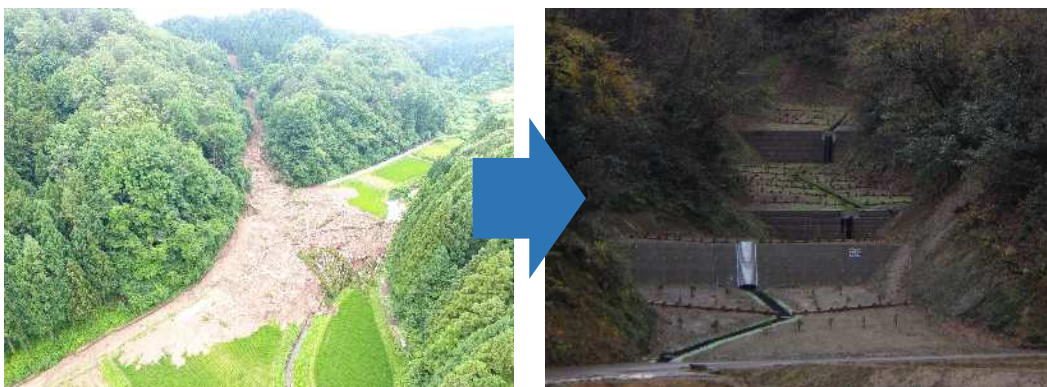
【山腹工（丹生郡越前町下山中）】
