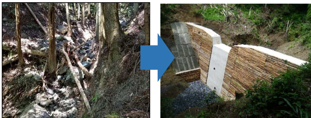
【治山ダム工（越前市中津原）】
