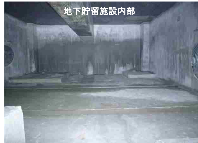
雨水貯留浸透施設の事例【横浜市内】
